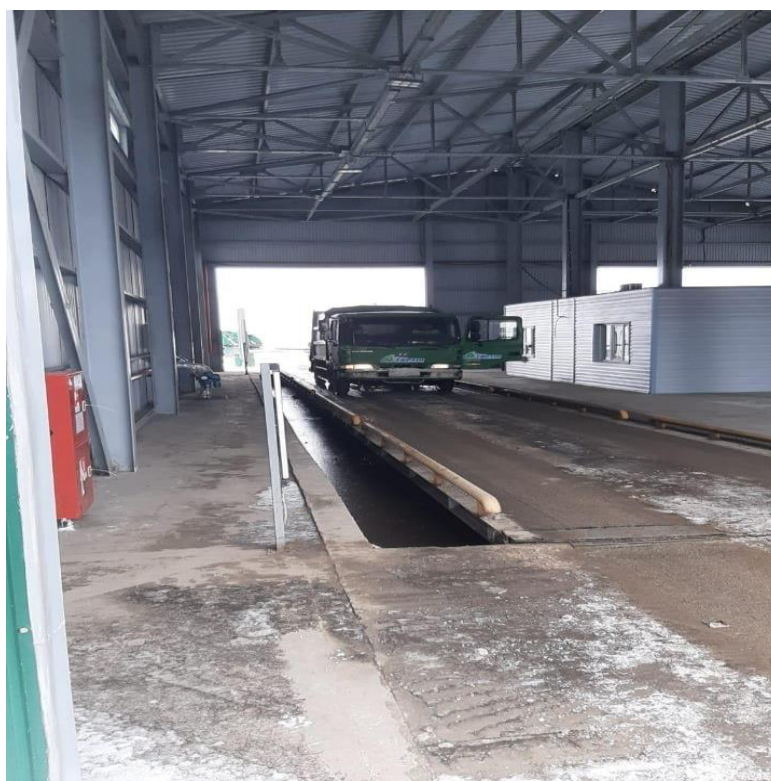
2.1 - сурет – Қоқыс таситын машинаны өлшеу және тексеру
